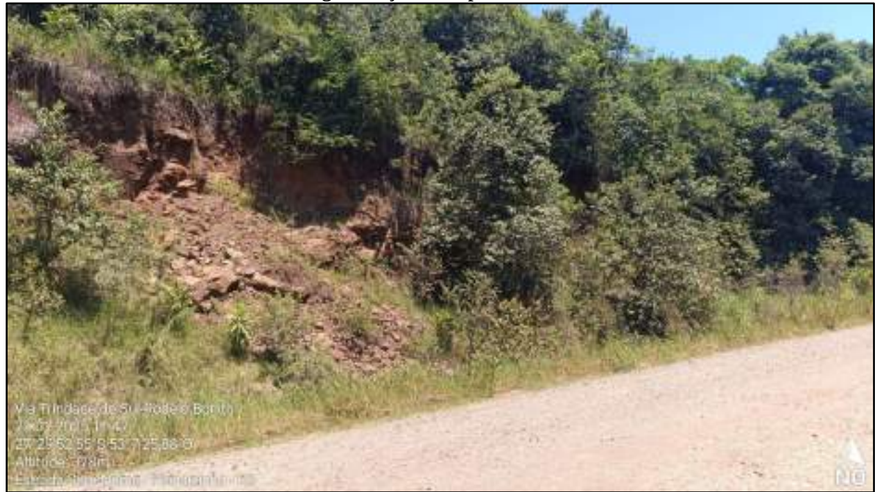
Figura 49. Surgência de talude de basalto exposto, no corte da estrada, onde a altura alcança 6 metros, possível verificar uma maior persistência de famílias de fraturas verticalizada, com ocorrência de fragmentação no topo do talude.
