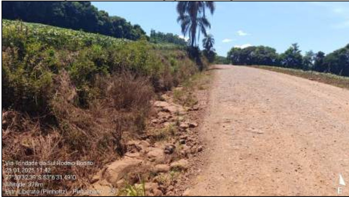
Figura 48. Acréscimo na situação topográfica após a localidade de Pinhalzinho, onde a presença de solo e basalto decomposto se mesclam em uma pequena camada aparente de menos de 1,0 metro.
