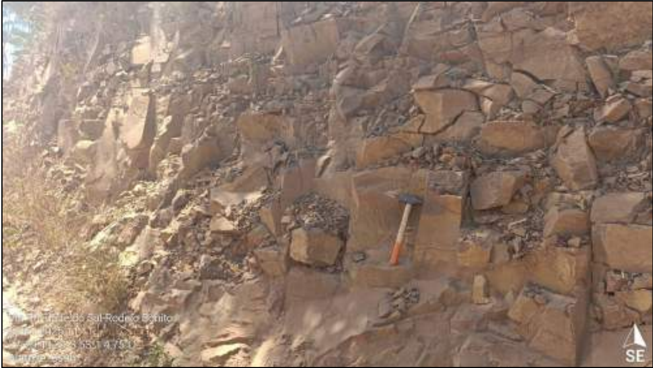
Figura 23. Talude encontrado ao lado da estrada, apresentando as condições geológicas locais.
