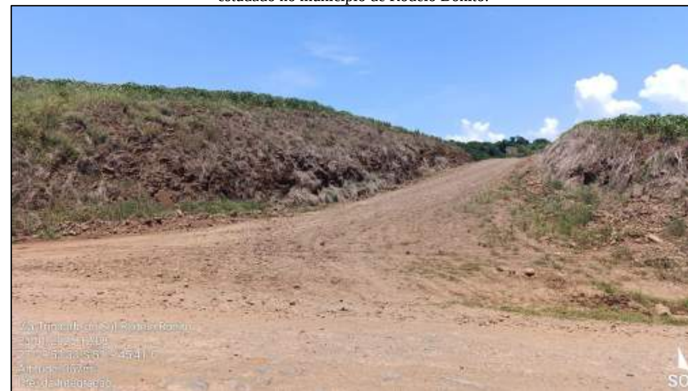
Figura 30. Solo mesclado com basalto decomposto, sendo difícil sua observância ao longo do trecho estudado no município de Rodeio Bonito.
