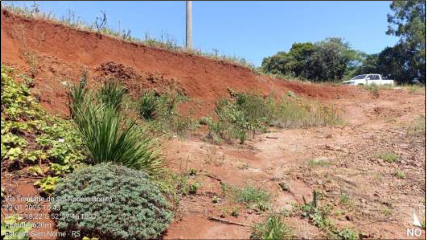
Figura 28. Perfil de solo encontrado próximo ao trecho da estrada, no município de Trindade do Sul.
