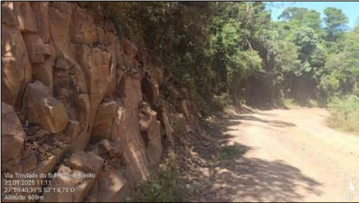
Figura 41. Na sede da localidade de Campina de Pedra há uma surgência de talude de basalto exposto de cerca de 4,0 metros, onde é possível verificar a matriz rochosa sã.
