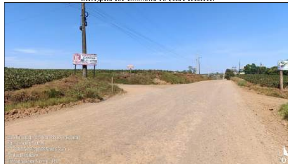
Figura 36.: Vista parcial da via nos primeiros 6 km, onde a presença de camada de solo e surgências litológicas são diminutas ou quase escassas.
